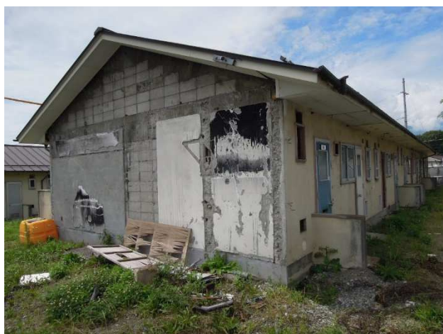
写真-1 除却する建築物の状況
