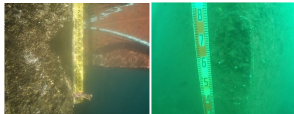
図-7 外壁の欠損（左：A函、右：B函）
