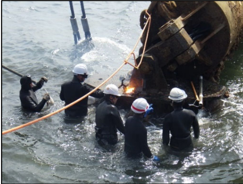
写真-9 タワーとシンカーの切り離し
