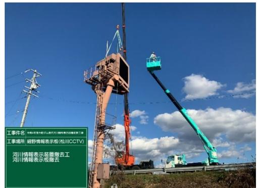
写真-10 細野情報表示板撤去作業の様子
