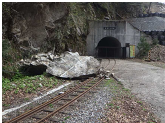
写真2 天鳥落石状況
