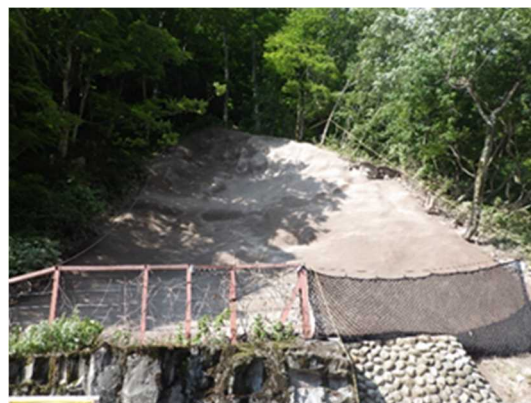
写真12 応急対策の全景
