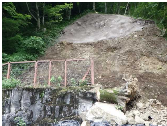
写真9 上部復旧状況（ECOバインド吹付後）
