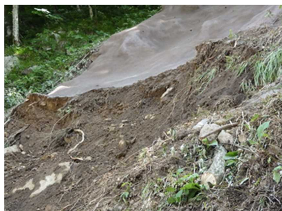
写真10 下部崩土除去後の状況
