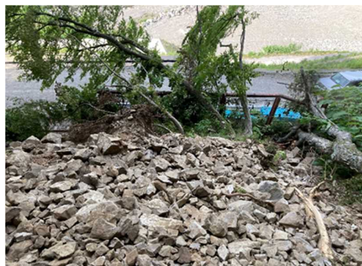
写真7 崩壊箇所下部の倒木
