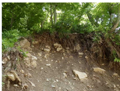
写真5 滑落崖の状況
