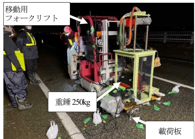
写真-1 載荷試験状況
