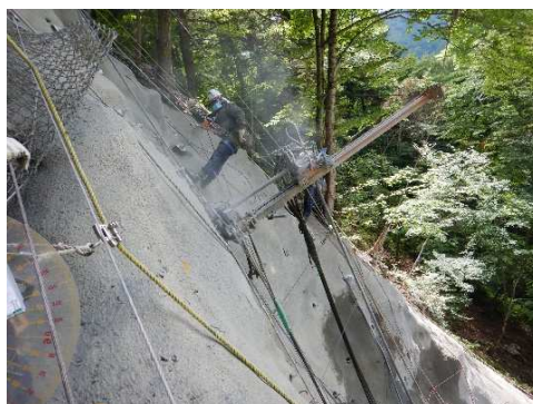
写真-3 削孔状況
