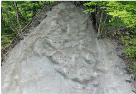
写真-4 鉄筋挿入位置の墨出し
