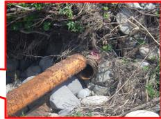
(写真12) ケーブル保護管 破断
