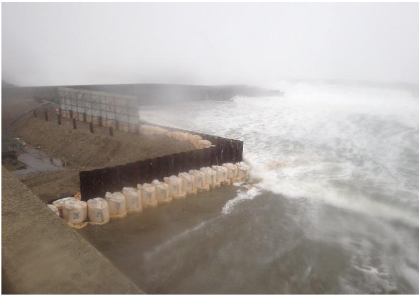
写真5 波浪状況 (P1橋脚)
