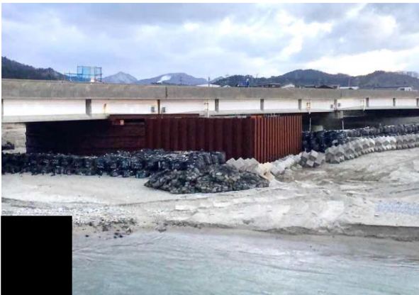
写真6 波浪対策 (P2橋脚)
