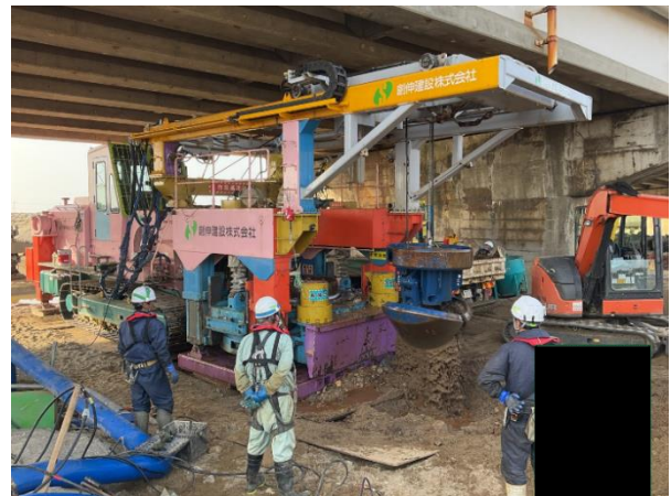
写真-4 鋼矢板打設地盤の砂置換え(P2橋脚)
