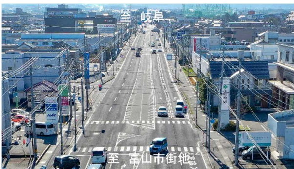
写真-1 黒崎電線共同溝PFI事業箇所の状況
