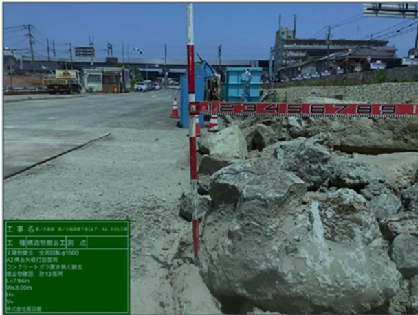
写真－7 コンクリートガラ (14.3m 3 )
