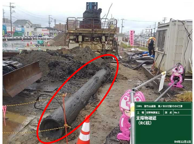
写真-6 引き抜かれたRC杭
