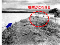
会津若松市飯寺地先の堤防決壊（洪水で堤防がこわれて、水があふれ出した＝浸水）
