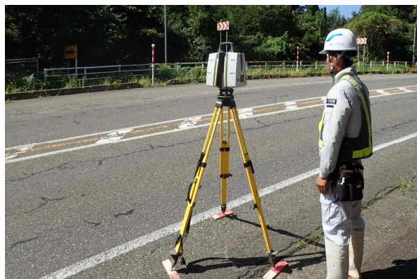
写真-1 TLS計測状況
