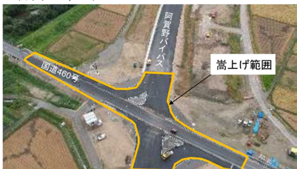
写真一三 交差点施工後
