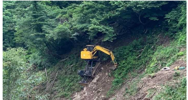
図-9 除根作業状況
