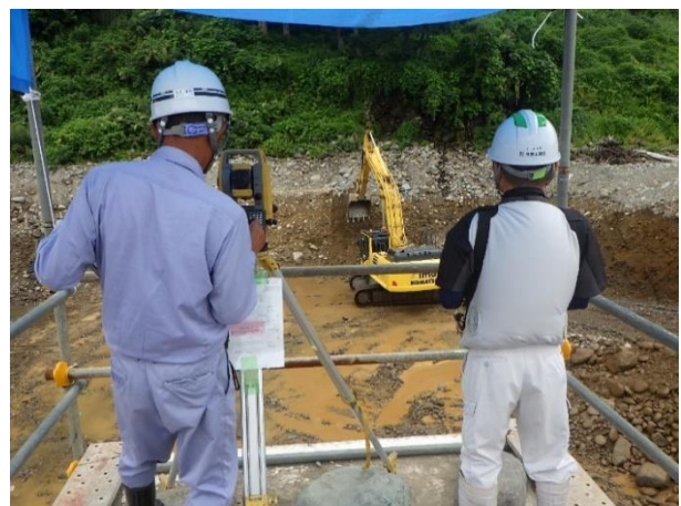
図-4 ノンプリズム測量機による無人化掘削
