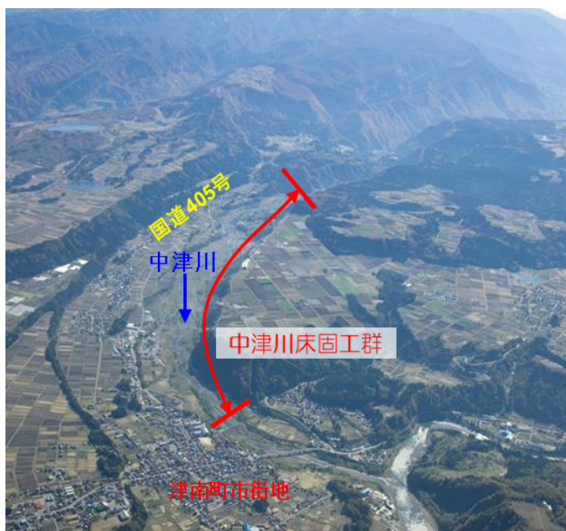
図-1 中津川床固工群遠景
