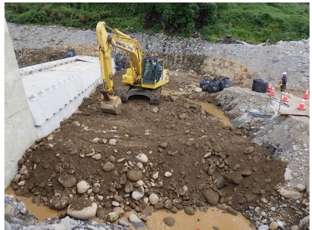
図-11 床固本体埋戻し
