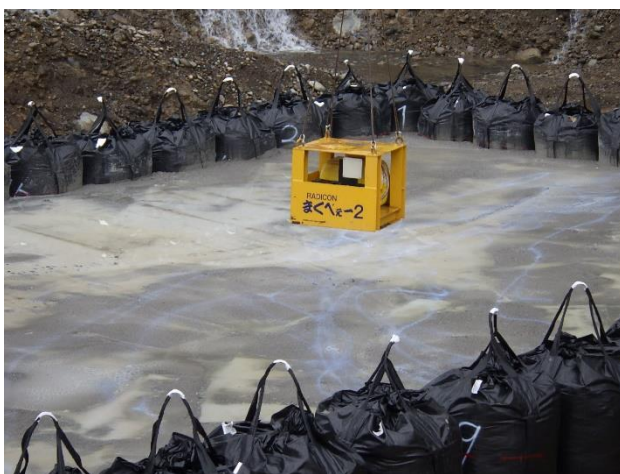
図-10 無人打継面処理剤散布機
