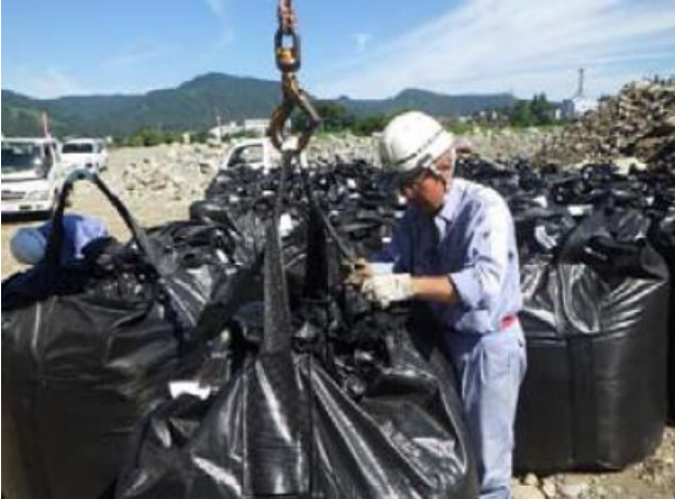
図-17 大型土のう吊帯部分の自立
