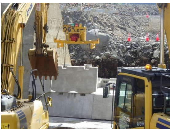
図-6 残存型枠ブロック据付
