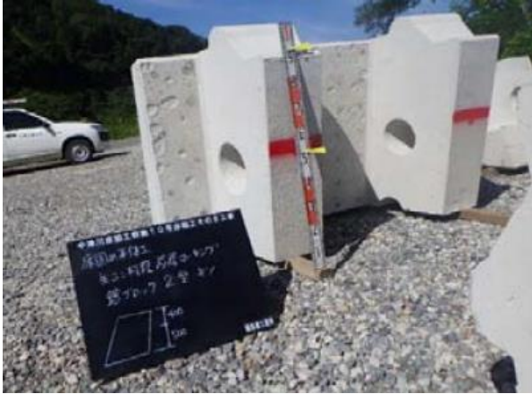
図-13 残存型枠ブロックのマーキング
