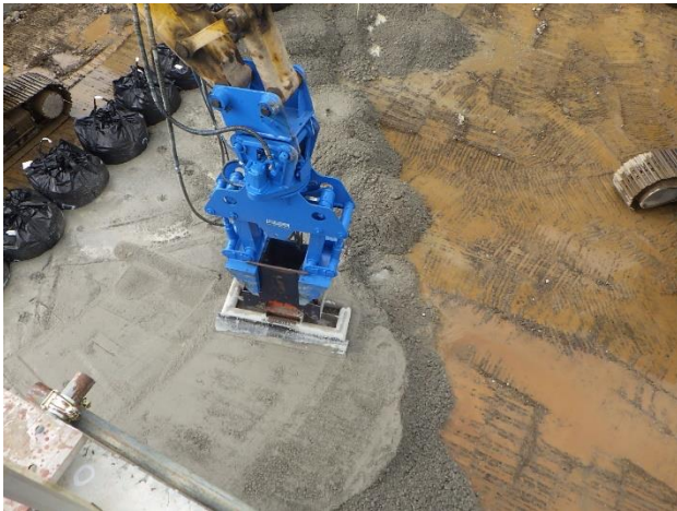
図-9 ベースコンクリート敷均し
