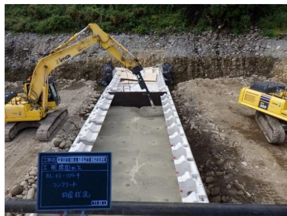
図-8 コンクリート締めめ
