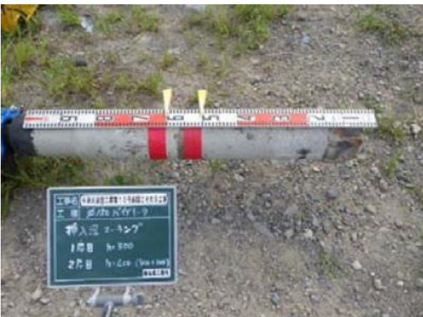
図-14 パイプレータのマーキング
