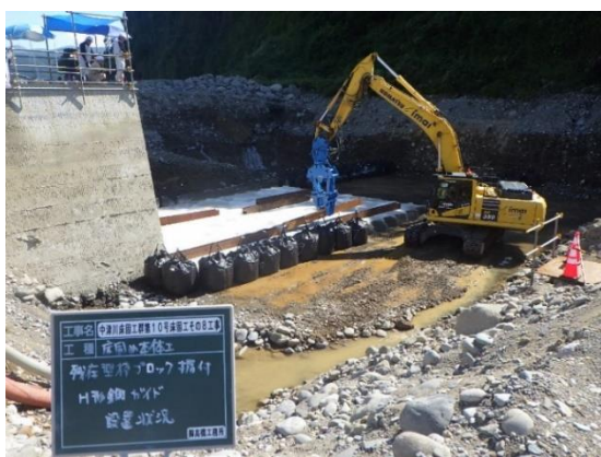
図-5 H形鋼ガイド設置
