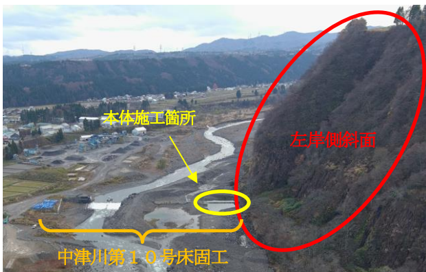
図-2 中津川第10号床固工及び左岸斜面
