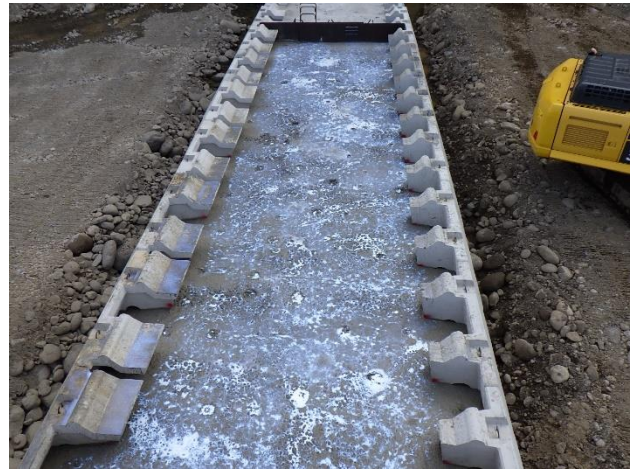
図-18 打継面処理剤散布後
