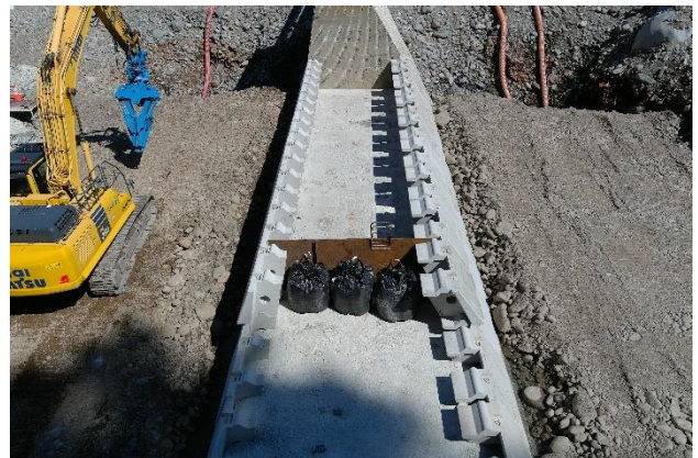
図-16 鉄板による仕切型枠
