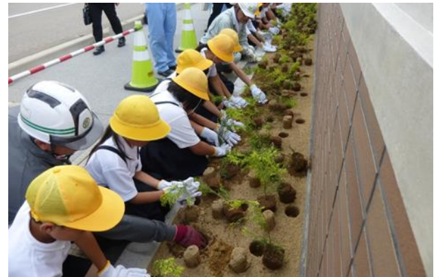
写真-10 小学校とのタイアップ（植栽工事体験）
