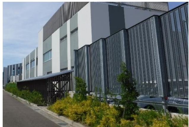
写真-4 敷地周囲の植栽帯及びフェンス
