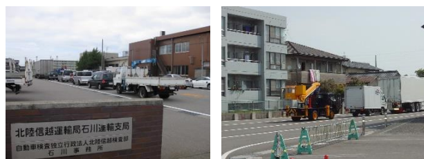
写真-1 旧構内（点検待ち車両の状況）
