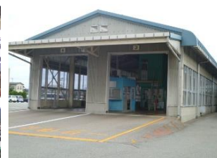
写真-3 旧庁舎 （検査場の外観）
