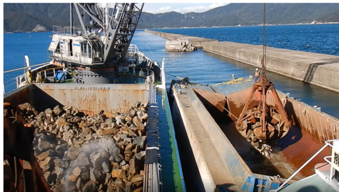
写真-2 底開式土運船による捨石投入作業
