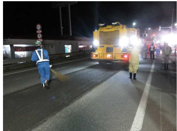
写真4 ICT舗装修繕工事の様子
