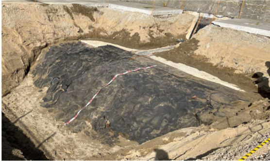
図-9 防砂シートの全景写真
