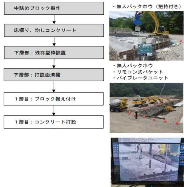
図-8 試験施工における主な作業フロー
