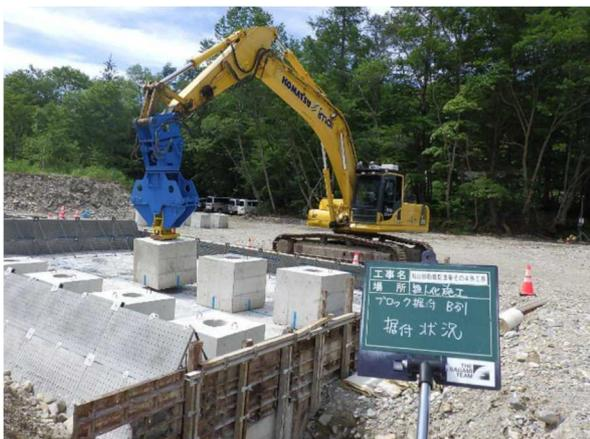
図-12 中詰めブロック据付け状況
