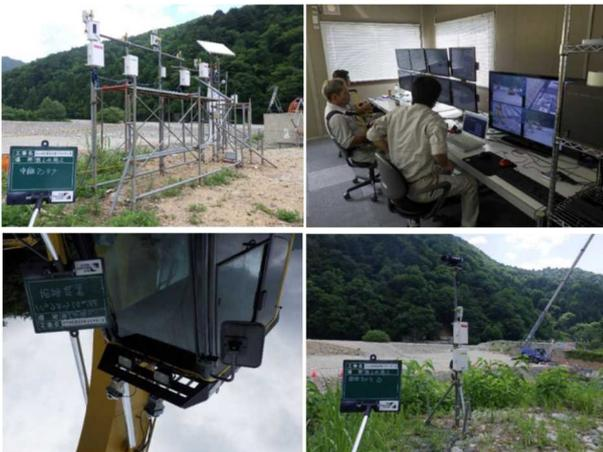
図-6 無線操作室及び固定カメラと車載カメラ
