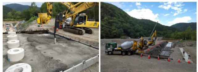
図-13 コンクリート打設及びバケット投入状況
