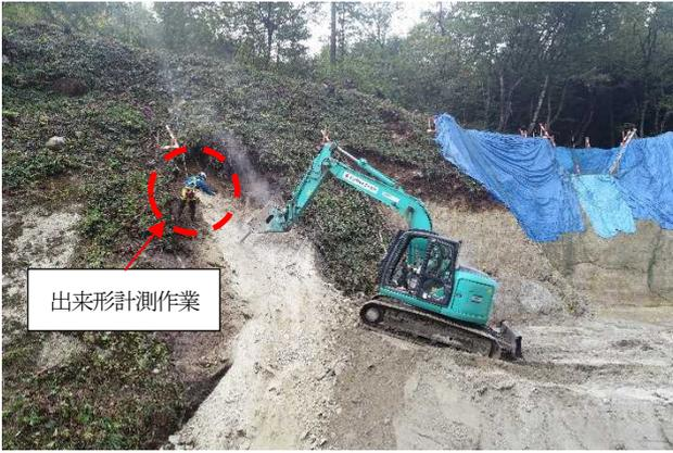
写真-1 従来の法面掘削状況写真
