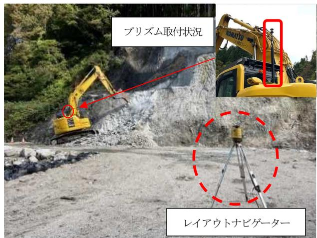
写真-2 杭ナビショベルを用いた施工状況
