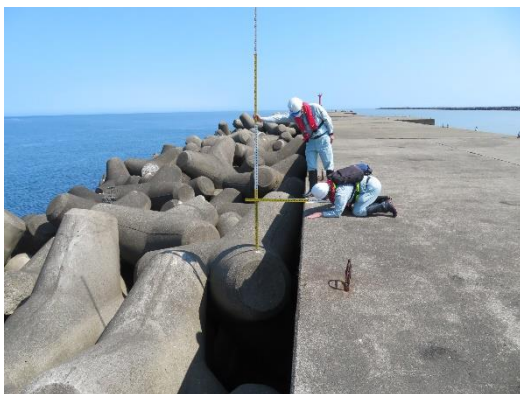
写真-3 消波ブロックの計測状況
