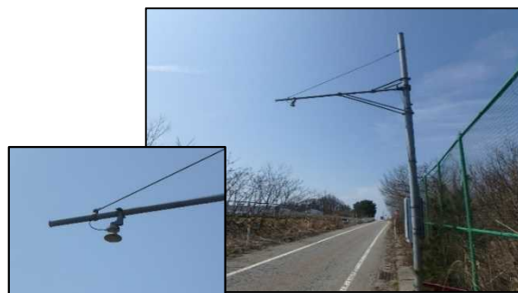
写真-1 トラカン設置状況
