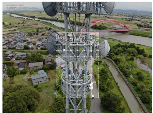
写真-5 飛行番号5 リング、支持架台外観
