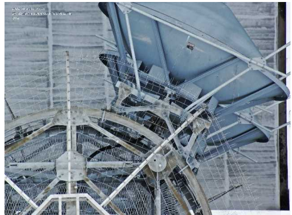
写真-4 飛行番号4 鉄塔上部
