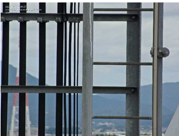
写真-8 飛行番号6 ケーブルラック・梯子の拡大画像
