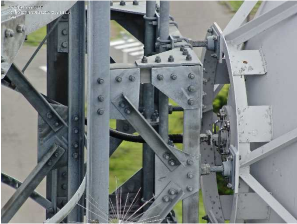
写真-6 飛行番号5 空中線支持架台の拡大画像
