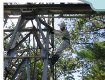
図-1 通信鉄塔点検の様子
