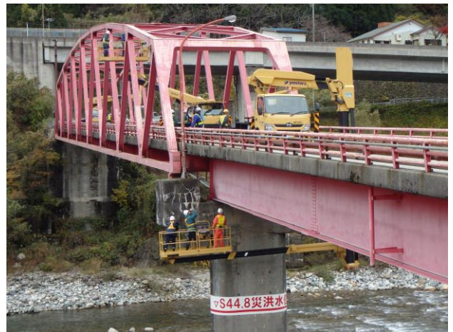
写真-1 橋梁診断状況
