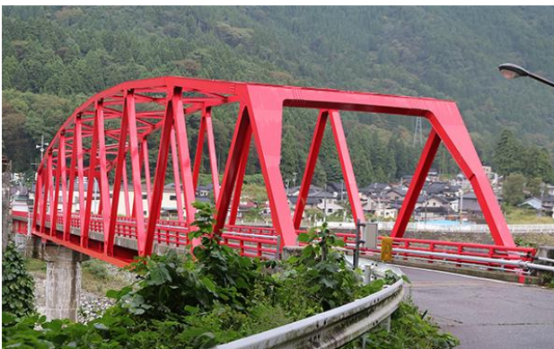
写真-9 修繕完了時の音沢橋
