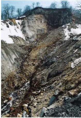
写真-5 標高1,300m崩壊地の全景 (社団法人地盤工学会蒲原沢土石流調査団, 1997)
