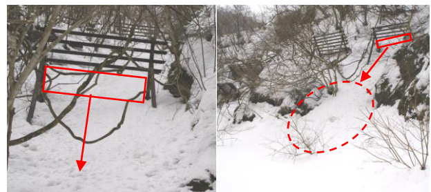
図-9 下部の横バーが複数欠落した雪崩予防柵と雪崩すり抜け事例
