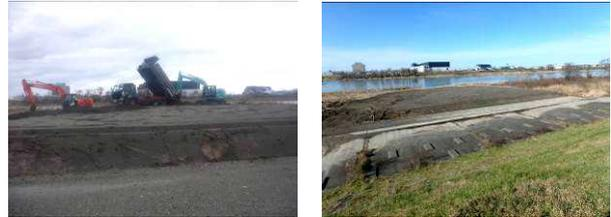
写真10 覆土の施工状況(左)と覆土後の状況(右)
