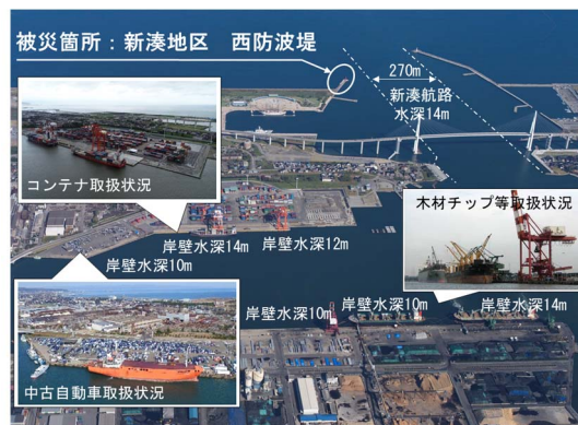
図-2 伏木富山港新湊地区西防波堤被災箇所
