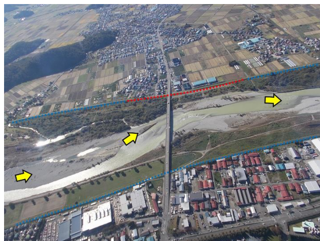
図-15 本郷大橋下流付近の状況
