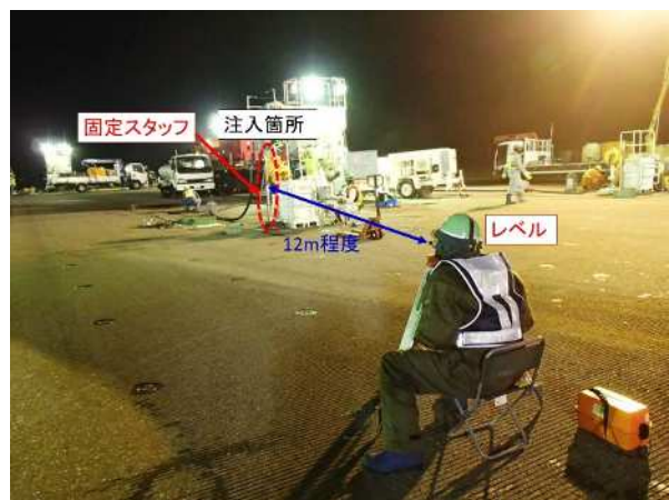
図-17 地点隆起量計測状況（注入作業時）
