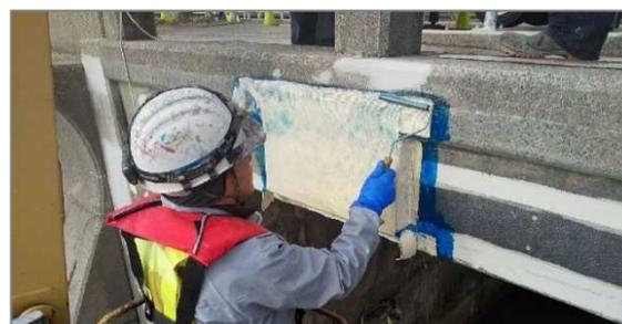
写真-7 PC横締め突出防止工
