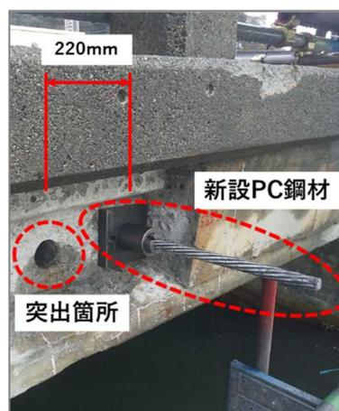
写真-6 緊張器具取り付け状況
