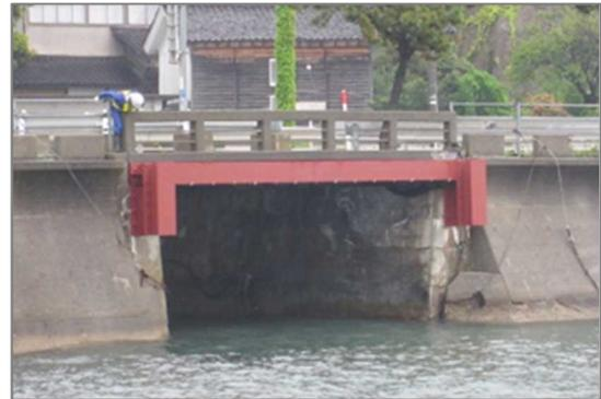
写真-4 応急対策工 (H形鋼の架設)
