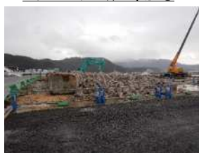
【方塊撤去工事】 方塊ブロック小割状況①
