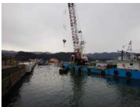
【方塊撤去工事】 方塊ブロック撤去状況①
