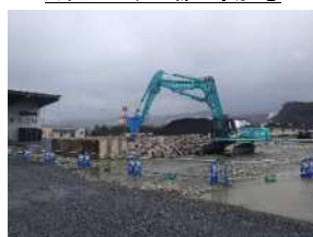
【方塊撤去工事】 方塊ブロック小割状況②
