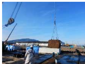
【方塊撤去工事】 方塊ブロック撤去状況②
