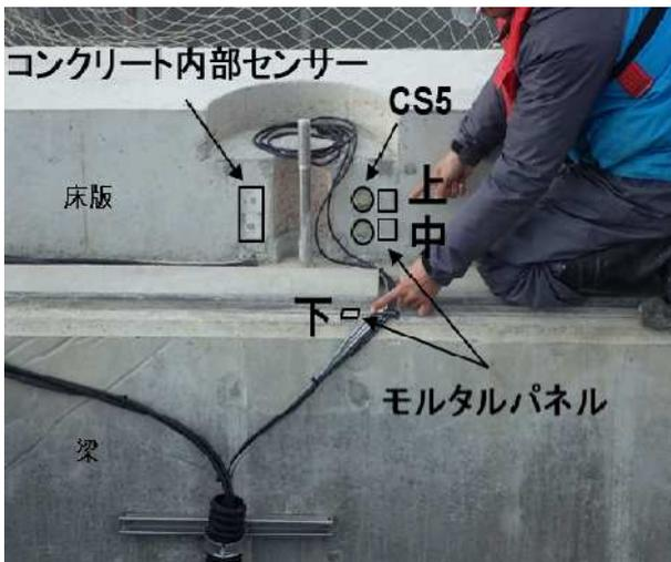
写真-5 梁内部計測機器設置状況
