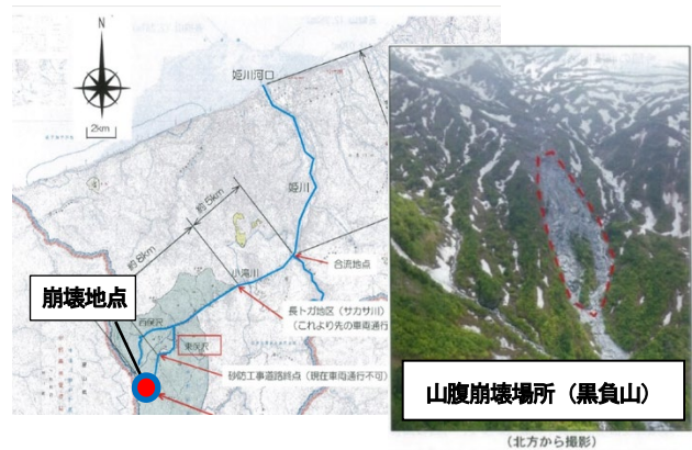
図-2 崩壊地の状況
