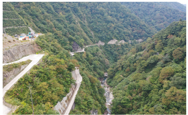
写真-4 無人航空機による撮影写真
