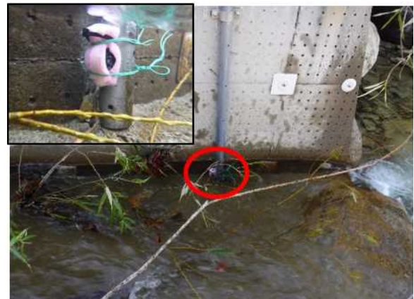
図-10 水中カメラ設置状況
