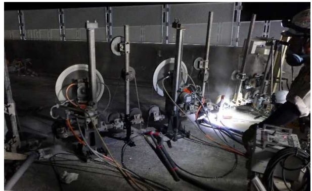
写真7 乾式ワイヤーソーによる上部工分割切断
