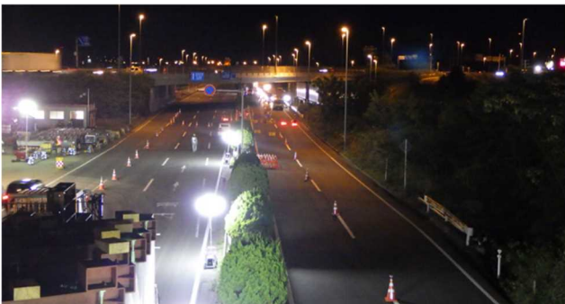
写真6 片側交互通行の規制材設置
