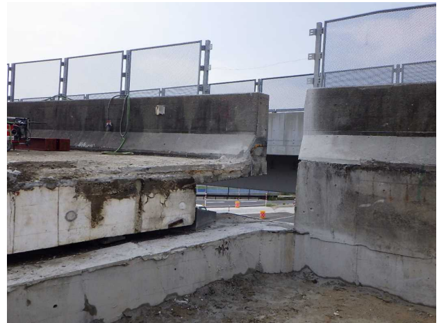
写真2 パラペット事前切断後の状況
