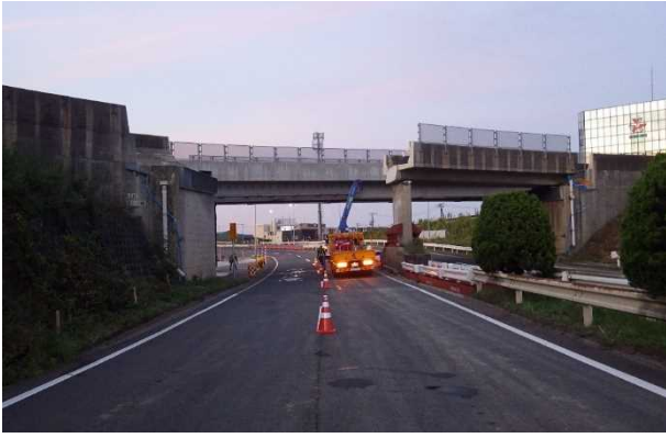
写真-9 上り線側上部工撤去後
