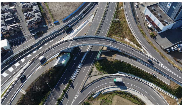
写真-11 上部工・橋脚の撤去後
