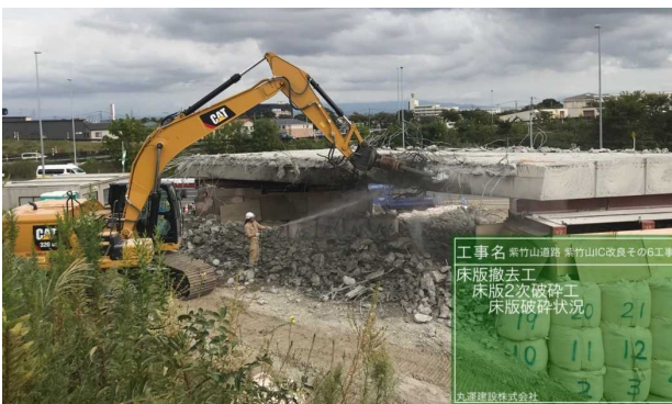
写真-12 解体ヤードでの上部工の破砕作業
