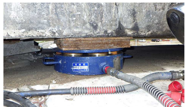
写真4 プレートジャッキによる支承の縁切り
