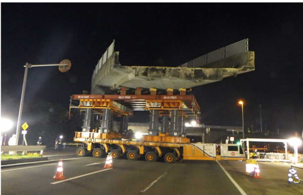
写真-10 下り線側上部工の運搬
