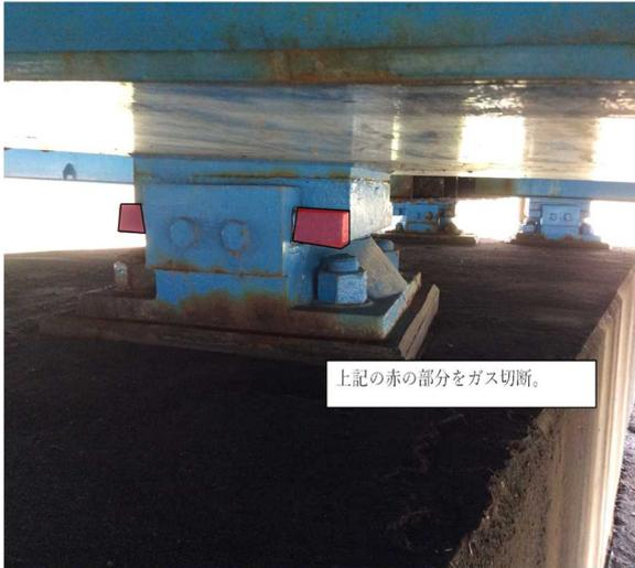
図-7 P17 橋脚支承の可動化
