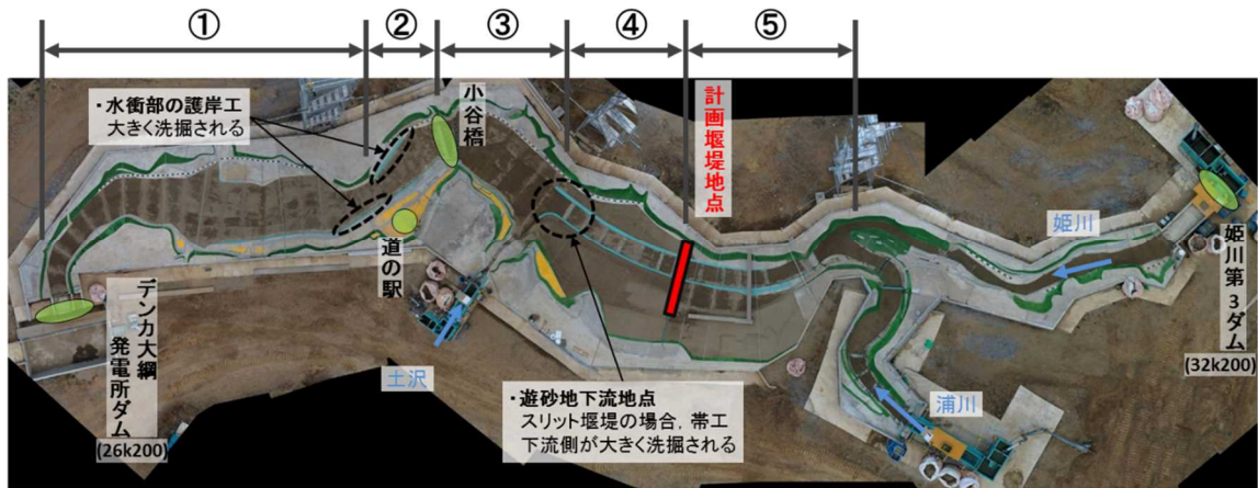
図-9 模型上での洗掘箇所
