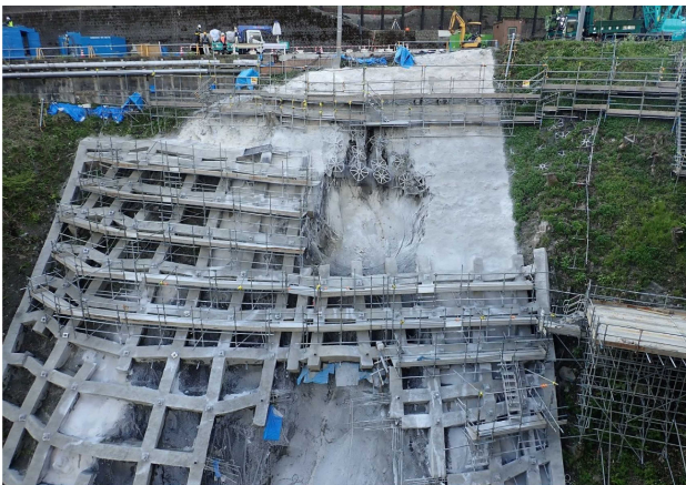
写真-3 モルタル吹付状況写真
