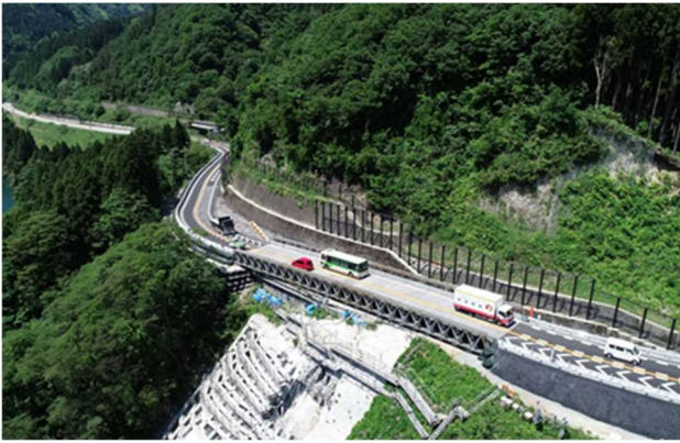
写真-2 応急組立橋による交通開放状況写真
