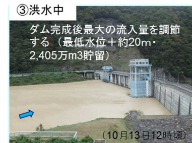
写真-5 洪水中ダム湖写真（令和元年10月13日12時頃）
