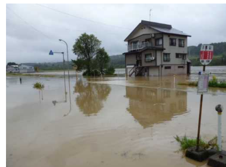
図2 台風19号による浸水被害(岩沢)
