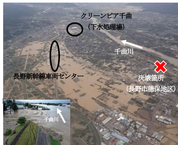
写真-1 浸水状況(2019年10月13日)及び長野市穂保地区の堤防決壊箇所(2019年10月13日6時20分頃)
