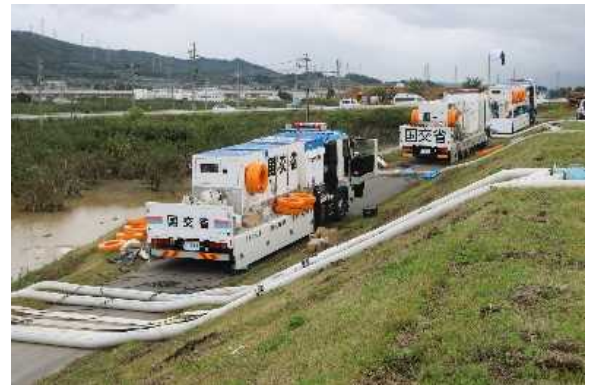
写真-3 緊急排水の実施状況（長野県小布施町）
