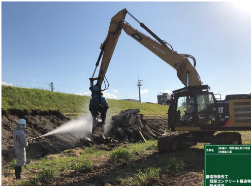
写真-4. 圧砕機を装着したバックホウ
