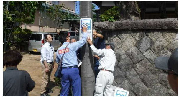
写真-1 設置状況
