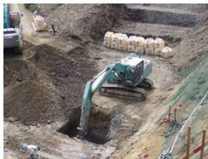
写真-4 エクステンションアームを取り付けたバックホウによる掘削
