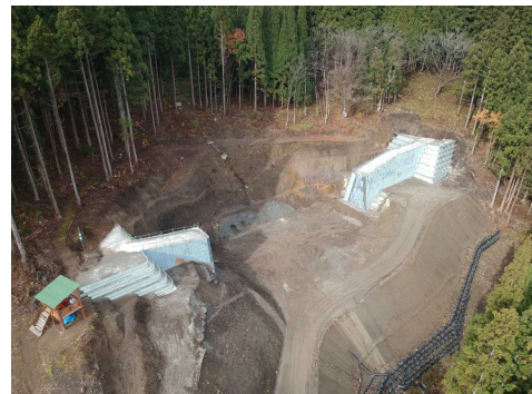
写真-2 施工状況 (R1.11撮影)
