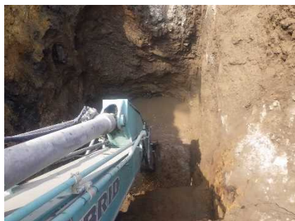
写真-3 掘削時の湧水状況
