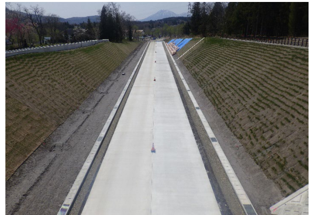
写真-10 連続鉄筋コンクリート舗装完成
