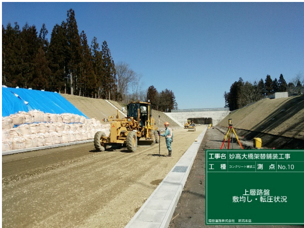
写真-2 路盤整正・転圧 (マシンコントロール)
