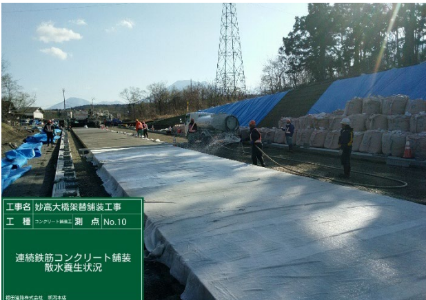
写真-8 養生マット設置
