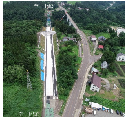
写真-1 連続鉄筋コンクリート舗装 施工箇所
