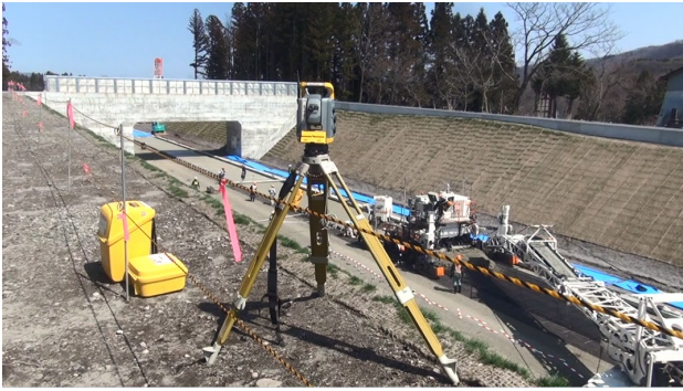
写真-6 打設状況 (マシンコントロール)
