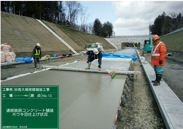
写真-7 粗面仕上げ
