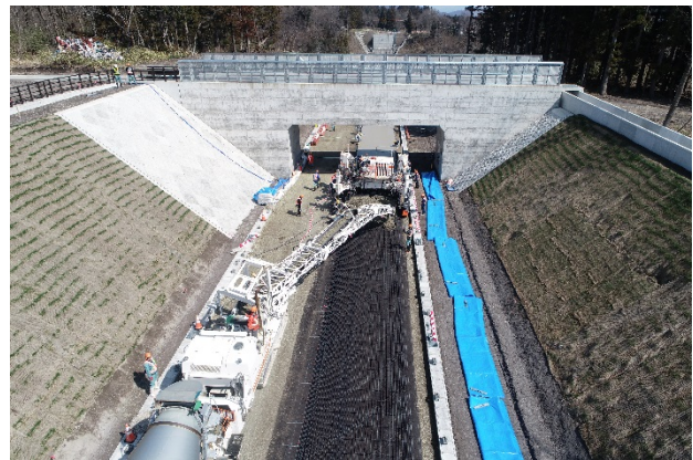
写真-4 打設状況 (長野県側より望む)
