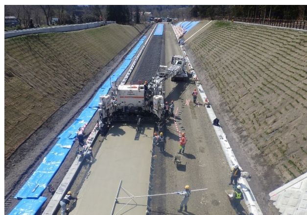
写真-5 打設状況 (新潟県側より望む)
