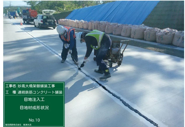
写真-9 縦目地材注入
