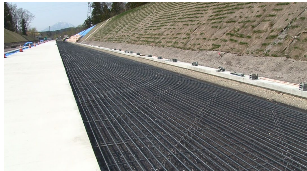
写真-3 鉄筋組立
