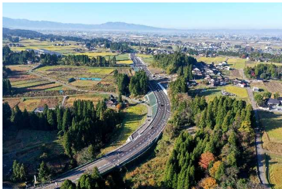
砺波東バイパス起点 砺波市芹谷 (R1.11.23 撮影)
