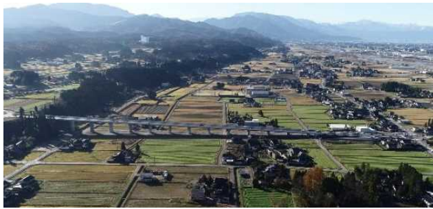
砺波東バイパス 伊加流伎（いかるぎ）大橋
