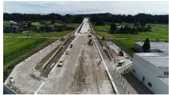
図-2 ICT建機による路盤施工①
