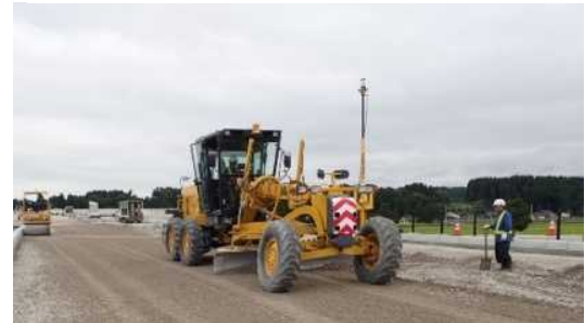
図-2 ICT建機による路盤施工②
